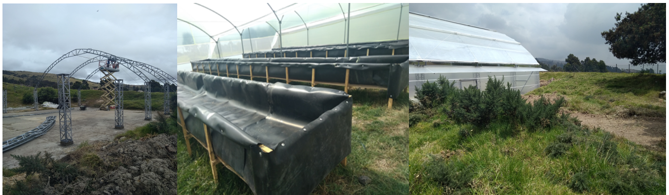
Adecuación planta de aprovechamiento
