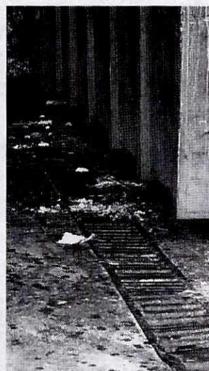
Condiciones de orden y aseo deficientes, ayudan a la proliferación de vectores. (23/10/2015 – 11:29 a.m)
