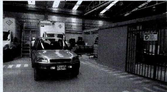
Adecuación de área de mantenimiento (23/10/2015 – 11:16 a.m)
