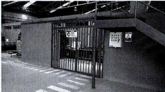
Adecuación de área de mantenimiento (23/10/2015 – 11:13 a.m)
