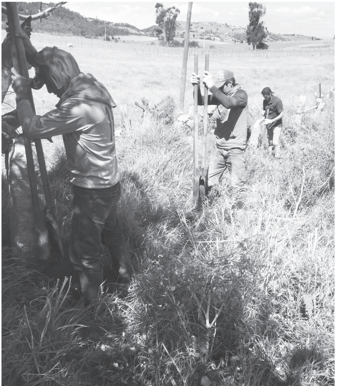
Reforzamiento de cercas en quebrada Aguas Calientes de Mochuelo Bajo.
