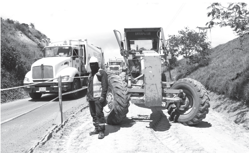
Extendido, nivelación y compactación de base granular.
