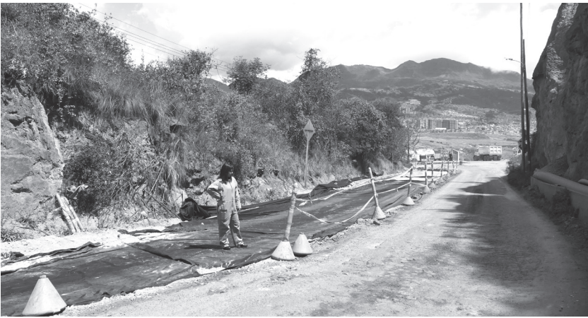
Señalización de obra e instalación de geotextil para separación entre capas granulares.
