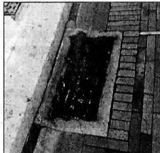
Foto No. 3 Acumulación de residuos sólidos sobre estructura hidráulica y deterioro de malla protectora C. Norte y Central
