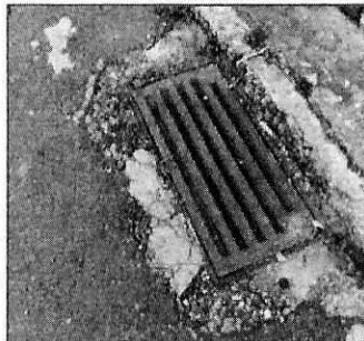
Foto No. 3 Acumulación de residuos sólidos sobre estructura hidráulica y deterioro de malla protectora C. Norte y Central
