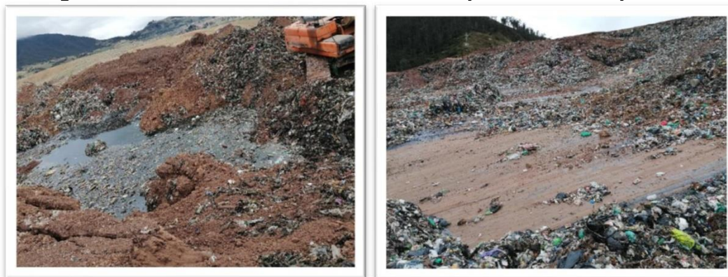
Imagen 11. Esguerrimiento de lixiviado sobre capa de arcilla "capa límite".
