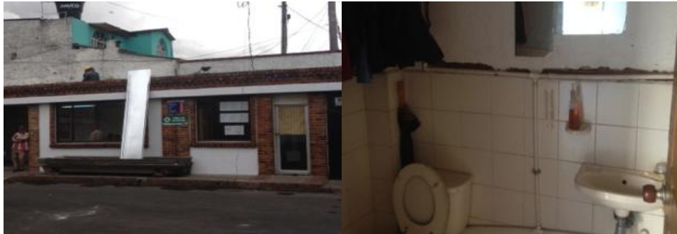
Foto 7 Área Administrativa del Centro de Acopio la Alquería Septiembre 2014
