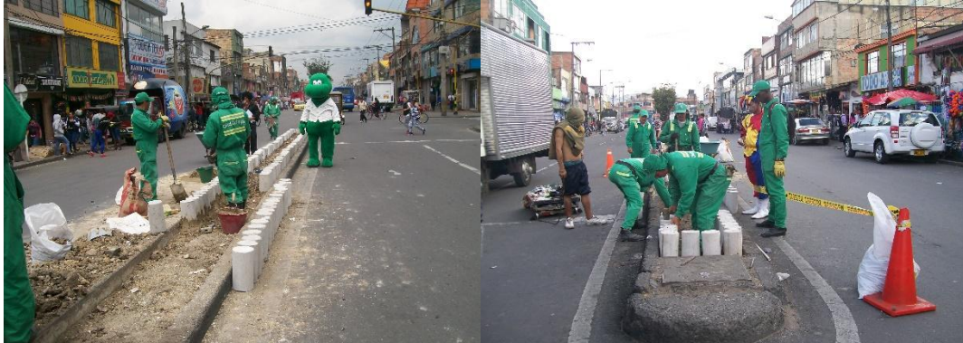
Foto 2 Separador Central Calle 38 Sur realizando la adecuación con plantación de individuos arbóreos.
