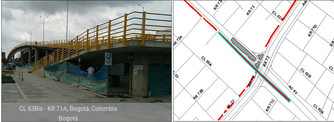
Ilustración 51 . Puente peatonal calle 63 con Avenida Boyaca
