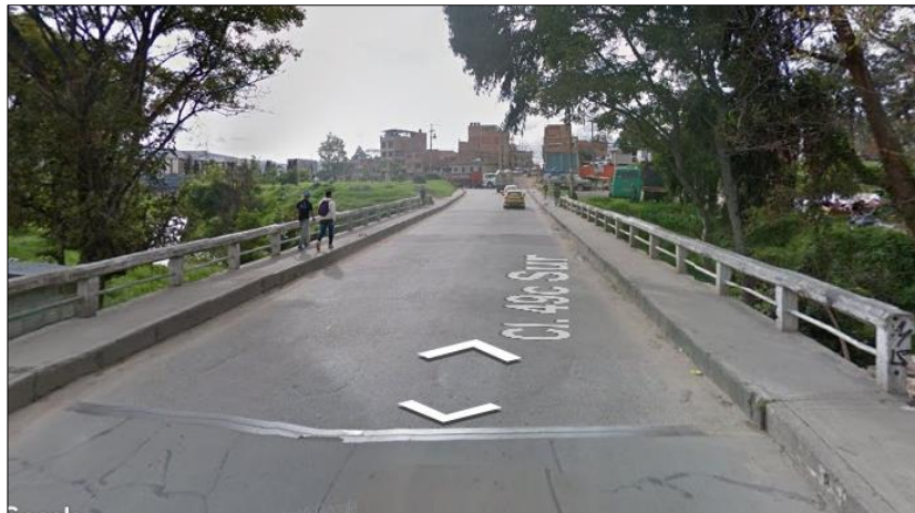
Ilustración 53. Ejemplo paso peatonal que no es puente
