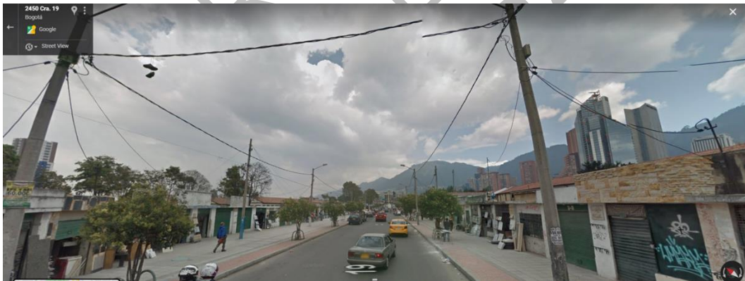
Fotografía 5: Estado Actual perfil Carrera 19
