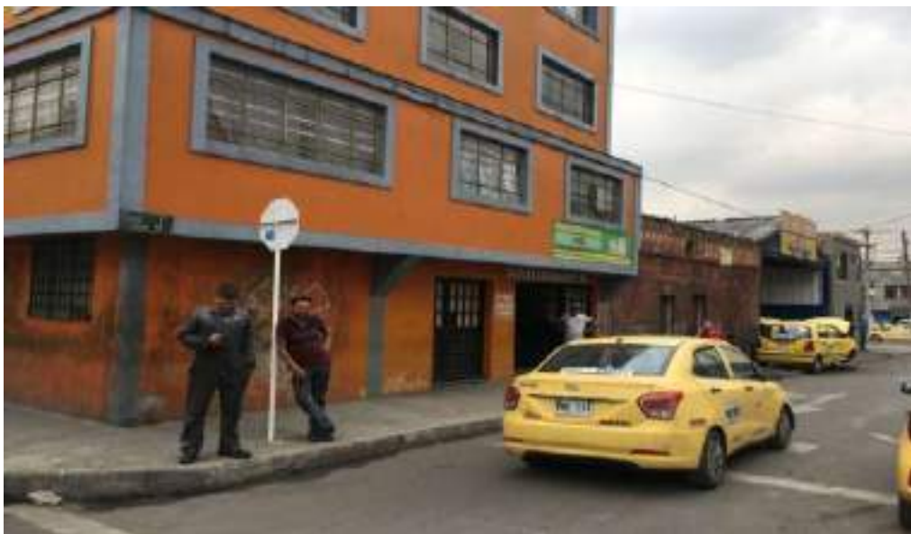
Imagen visita administrativa realizada por la Personería de Bogotá realizada el 28/09/2022
