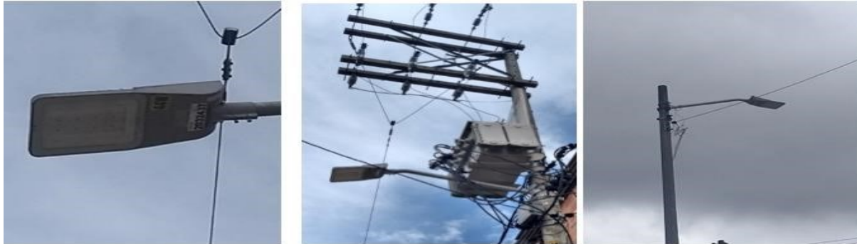
IMAGEN No. 1 INFRAESTRUCTURA UBICADA EN LA LOCALIDAD DE RAFAEL URIBE
