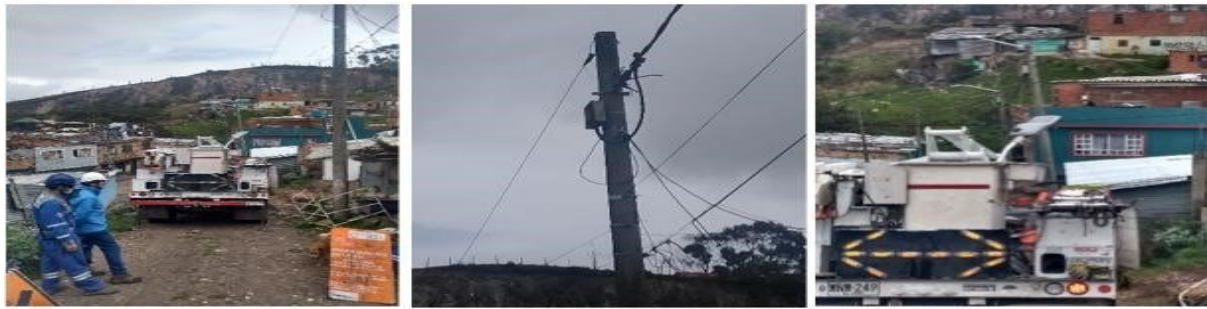
IMAGEN No. 2 PROCESO OPERATIVO INSTALACIÓN ALUMBRADO PÚBLICO LOCALIDAD DE USME – PROCESO DE MODERNIZACIÓN DE ALUMBRADO PÚBLICO
