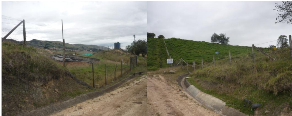
Imagen 4-4 Cerramiento de la Celda de Seguridad
