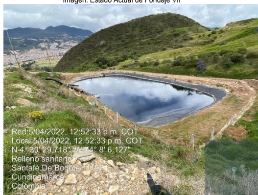
Imagen. Estado Actual de Pondaje VII
