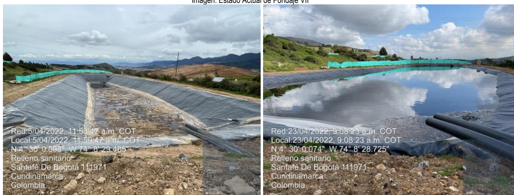
Imagen. Estado Actual de Pondaje VII
