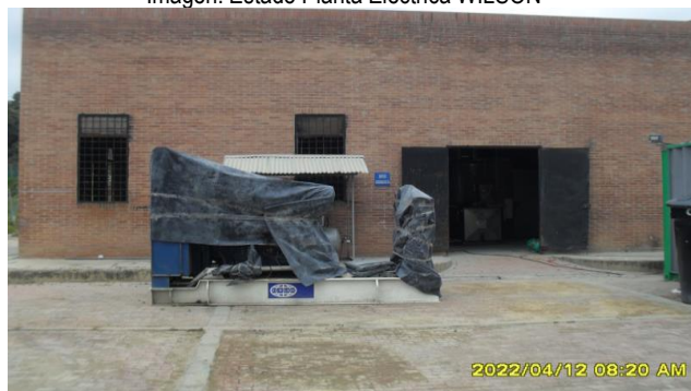
Imagen. Estado Planta Eléctrica WILSON
