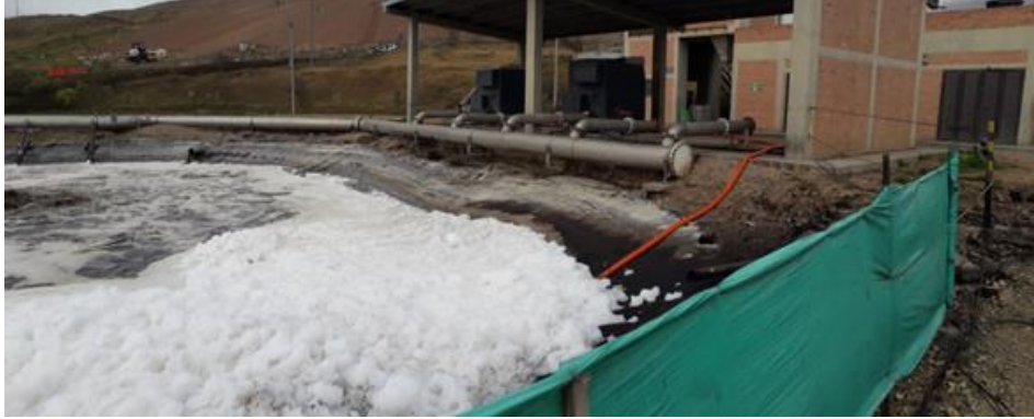
Imagen. Reactor SBR Norte
