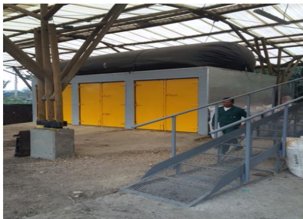
Biodigestor tipo Fermentación en seco en operación – Tablero eléctrico
