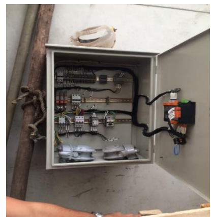
Biodigestor tipo Fermentación en seco en operación – Tablero eléctrico
